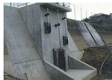
明石市の血池(西脇)での緊急放流設備の整備
