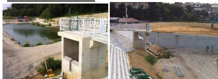
明石市の林谷池での緊急放流施設、洪水吐改修等の整備
