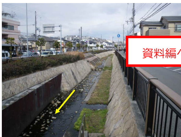
図-22—朝霧川下流部
