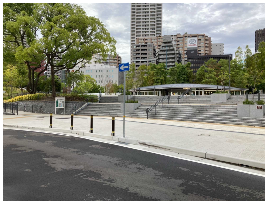
歩道の透水性舗装(神戸市東遊園地周辺)
