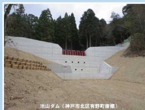
治山ダム（神戸市北区有野町南側）
