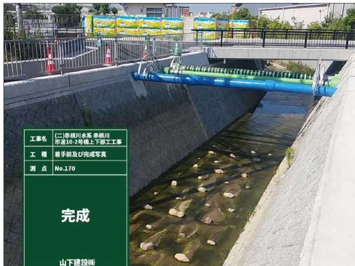
河川対策の具体例(赤根川河川改良事業) ・護岸工、河床掘削、橋梁架替
