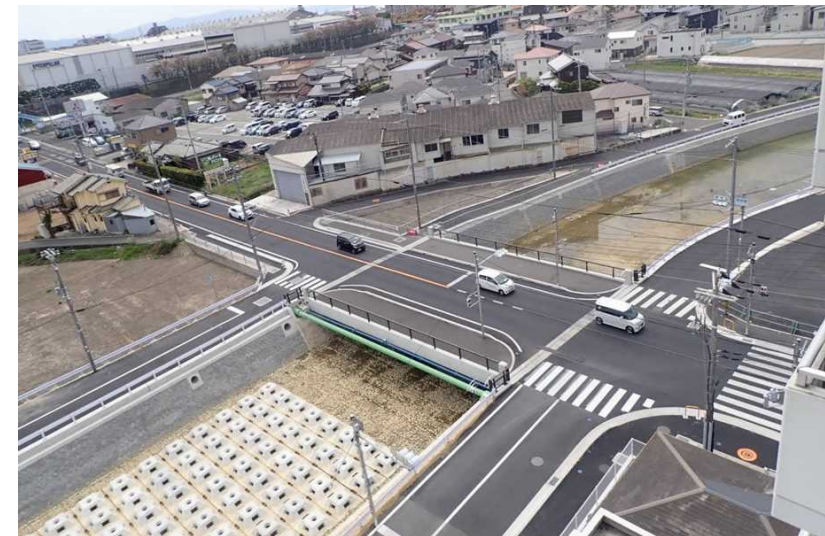
河川対策の具体例(瀬戸川改修事業) ・護岸工、河床掘削、井堰改築、道路橋架替
