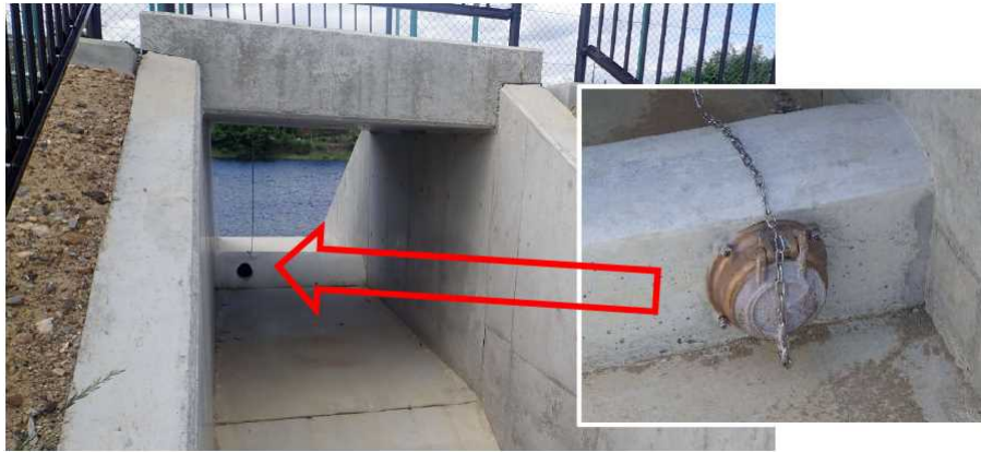
ため池改修にあわせた事前放流設備の整備（左：尻池、右：溝谷池（神戸市西区））
