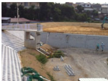
明石市の林谷池での緊急放流施設、洪水吐改修等の整備
