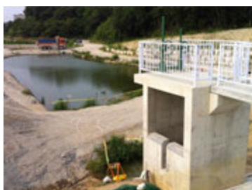
明石市の林谷池での緊急放流施設、洪水吐改修等の整備
