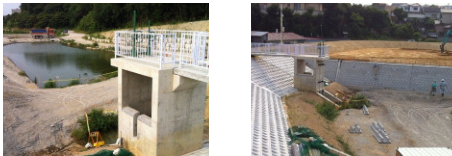
工事中の谷池（明石市）
