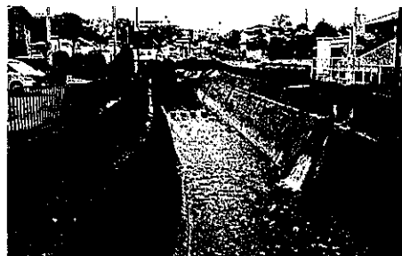
駄六川 施工後(北伊丹谷口橋上流側)
