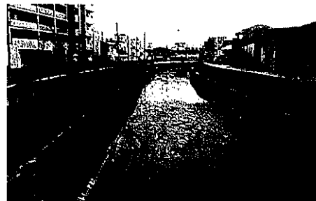
駄六川 施工後(北河原政木橋下流側)
