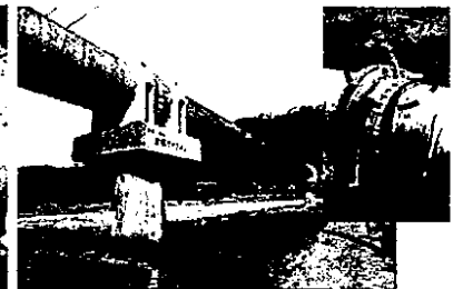
管の継ぎ目からの漏水 (曾根サイフォン、加東市)
