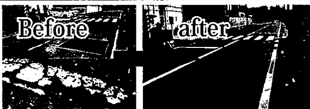
県道姫路神河線(67号線)舗装工事
