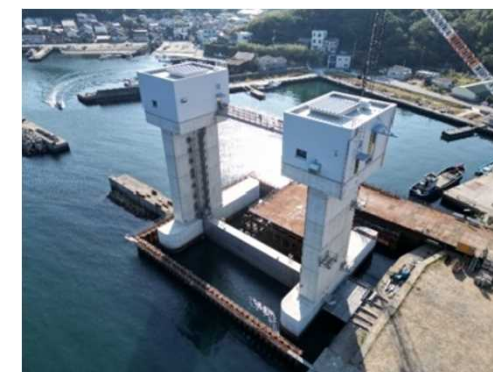
沼島漁港 水門（南あわじ市）
