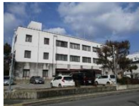
【長寿命化改修中のたつの警察署】
