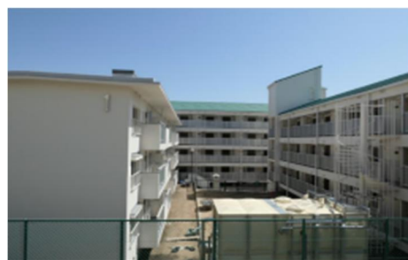
【職員住宅を改修したウイング須磨寺等】
