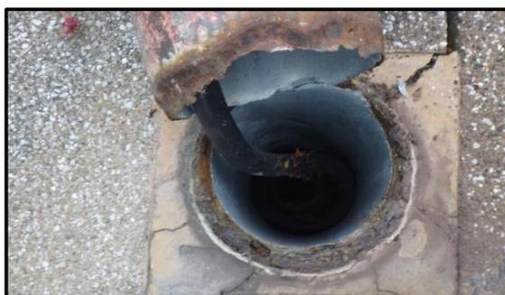
【倒壊した信号柱の地際部】
