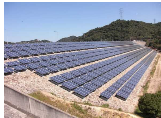
【権現ダム堤体法面】
