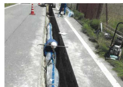
播磨支線管路耐震化工事
