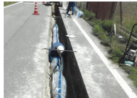
【播磨支線管路耐震化工事(過年度)】
