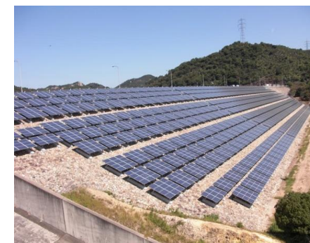
【権現ダム堤体法面】
