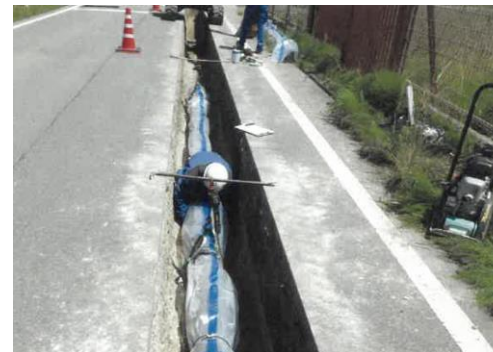
【播磨支線管路耐震化工事(過年度)】
