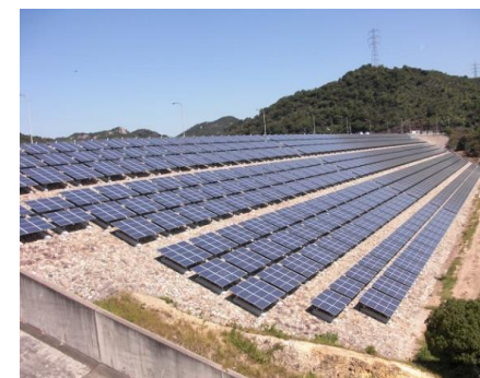
【権現ダム堤体法面】
