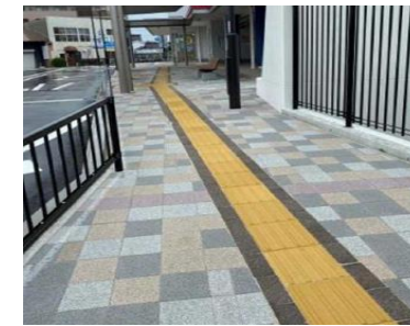
助言の例：点字ブロック周囲のコントラスト
