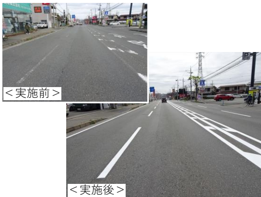
道路区画線の引き直し
