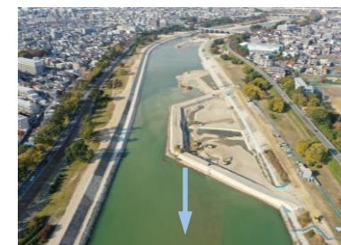
武庫川 河川改修(1号床止撤去)
