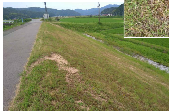
国管理河川の植生転換の施工事例：改良シバ
