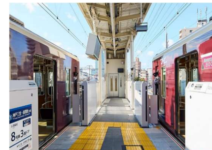
写真2 エレベーター設置 (阪急春日野道駅)
