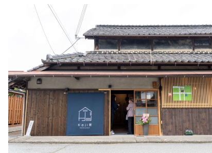
写真6 空き家の宿泊施設への改修事例
