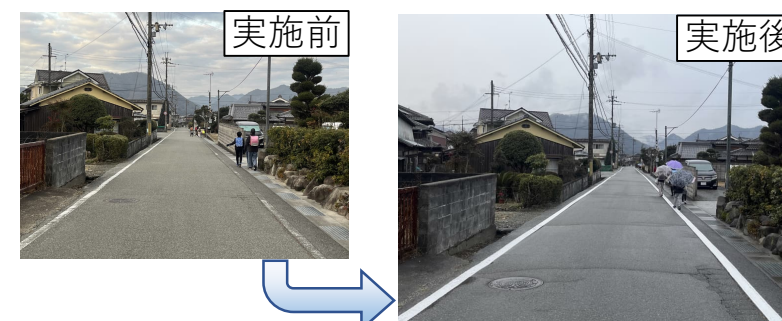
道路区画線の引き直し（西脇市）
