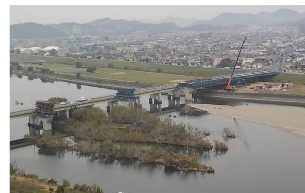
都市計画道路 国道2号線 加古川橋（加古川市）
