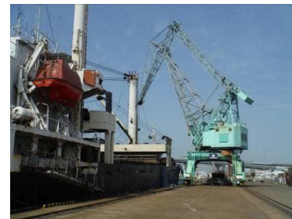
尼崎西宮芦屋港東海岸町地区 県営クレーン（尼崎市）
