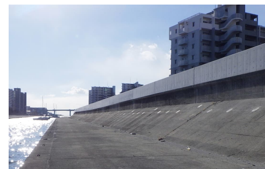
尼崎西宮芦屋港海岸 枝川町地区 防潮堤嵩上げ（西宮市）
