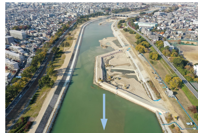
武庫川 1号床止撤去（尼崎市、西宮市）
