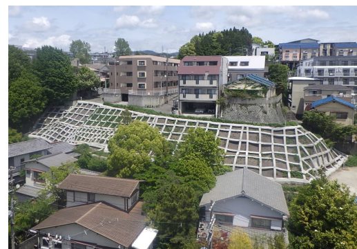
鈴蘭台北町(4)地区 急傾斜地対策 (神戸市)
