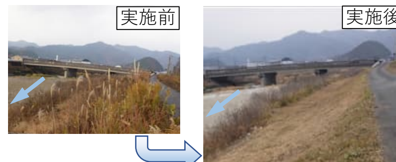
河川堤防の点検前除草（多可町）
