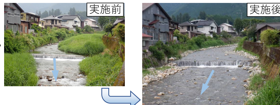
岩野辺川 堆積土砂撤去（宍粟市）
