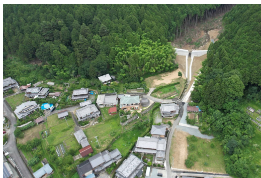
古瀬畑川 砂防堰堤 (姫路市)
