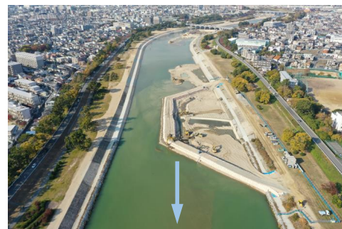
武庫川 1号床止撤去(尼崎市等)
