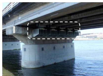
国道250号 汐見橋 落橋防止装置・橋脚補強(姫路市)
