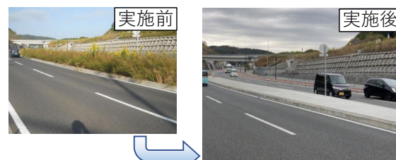
中央分離帯の張りコン (川西市)
