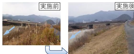
河川堤防の点検前除草 (多可町)
