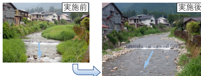
岩野辺川 堆積土砂撤去（宍粟市）
