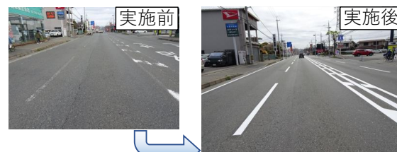
道路区画線の引き直し (宝塚市)
