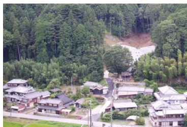
西山川 砂防堰堤（市川町）
