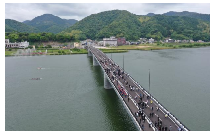
県道 豊岡竹野線 城崎大橋 (豊岡市)
