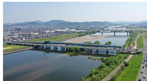
都市計画道路 国道2号線 加古川橋 (加古川市)
