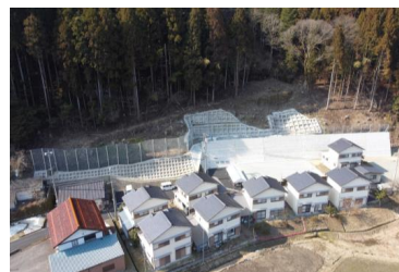
和田地区 急傾斜地対策（香美町）
