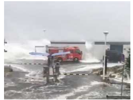
【南芦屋浜南護岸・越波状況】
