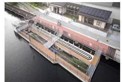
【北堀運河(水質浄化施設)】
