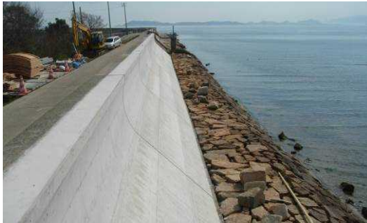
【御津海岸・護岸補修】
