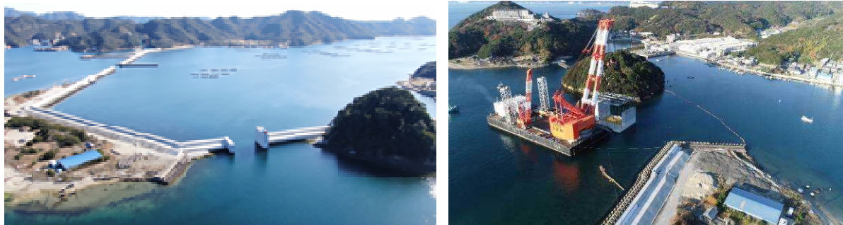
【福良港海岸・湾口防波堤】
