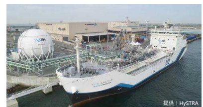
参考：神戸港で実証が進む液化水素の運搬船と貯蔵タンク
