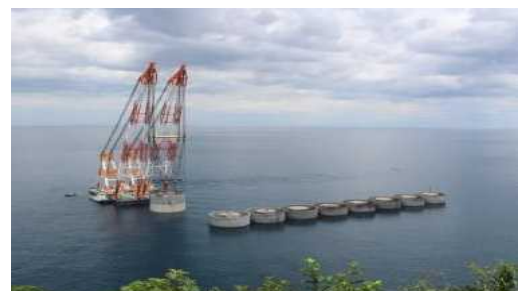
【柴山港(防波堤)・新設】
