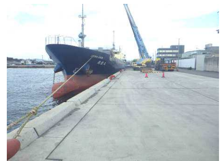
【中島地区(-5.5m 岸壁・老朽化対策)】
