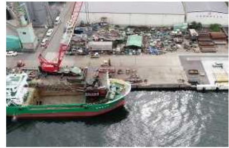
【姫路港須加地区(-3.5m 物揚場・老朽化対策)】
