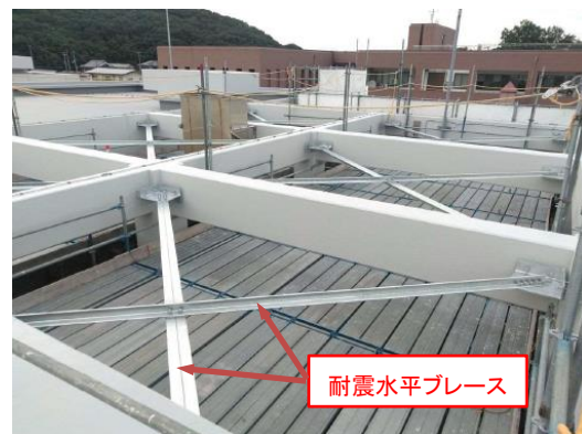
耐震水平ブレース設置等による 受変電棟耐震化(加古川上流浄化センター)
