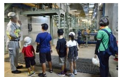
揖保川浄化センター
