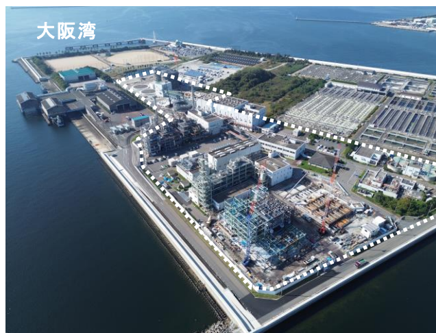
兵庫東流域下水汚泥広域処理場 全景
