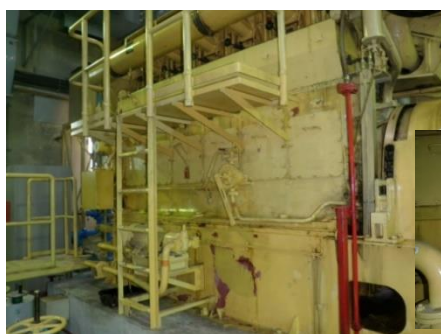
施設の劣化状況（左：雨水ポンプ用エンジンH6年製 オイル漏れ 右：遠心濃縮機H5年製 内部の亀裂）
