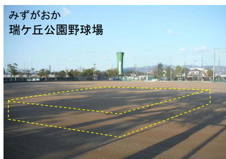
野球場の地下に設置した雨水貯留施設（伊丹市）
