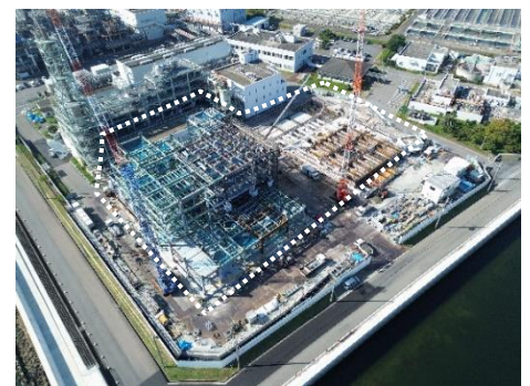
固形燃料化施設 施工状況 (兵庫東流域下水汚泥広域処理場)
