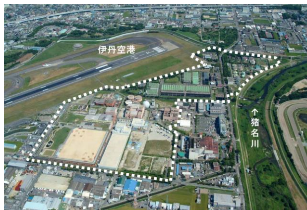
原田処理場 全景
