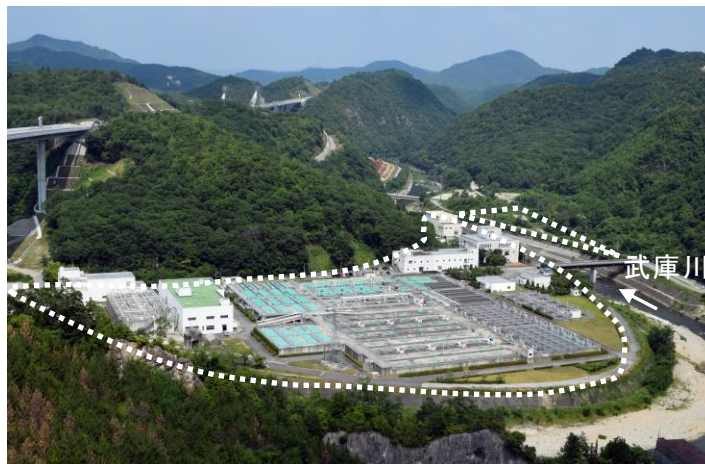
武庫川上流浄化センター 全景
