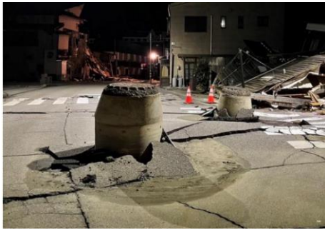
マンホールの浮上(輪島市)
