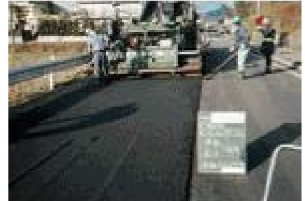
熔融スラグを活用したアスファルト舗装 （兵庫西流域下水汚泥広域処理場）
