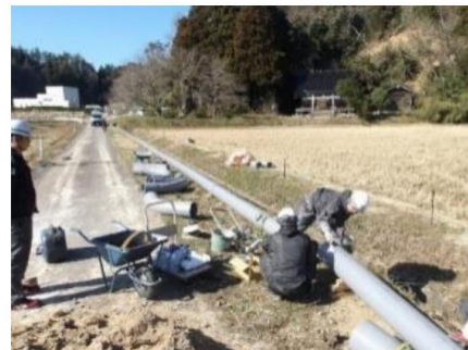
下水圧送管の復旧状況(珠洲市)
