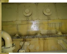
施設の劣化状況（左：雨水ポンプ用エンジンH6年製 オイル漏れ 右：遠心濃縮機H5年製 内部の亀裂）
