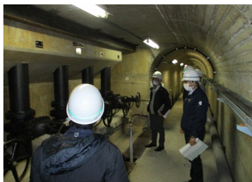
取水ゲート点検 菅生ダム(姫路市)
