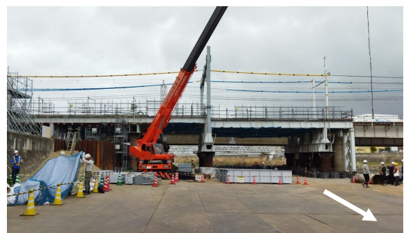
JR 橋梁改築 明石川（明石市）
