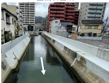
防潮堤のかさ上げ 高橋川（神戸市東灘区）
