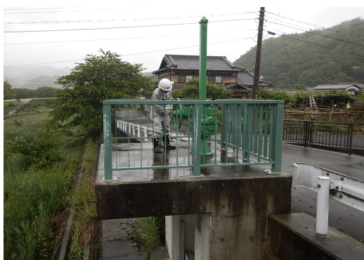
樋門点検 矢野川(相生市)
