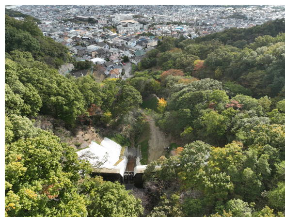
武庫川ブロック（宝塚市） 西山川堰堤工（R6年9月完成）
