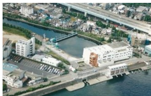
松島排水機場（尼崎市）
