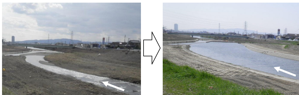
堆積土砂撤去 明石川（神戸市西区）
