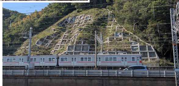
塩屋谷ブロック（神戸市垂水区） 斜面对策工（R5年6月完成）
