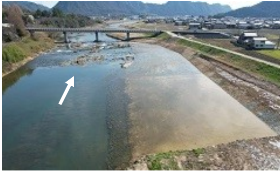
河床掘削 加古川(西脇市)
