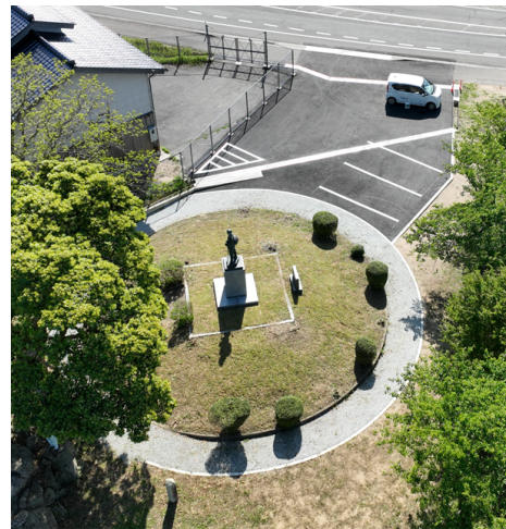
駐車場の整備
