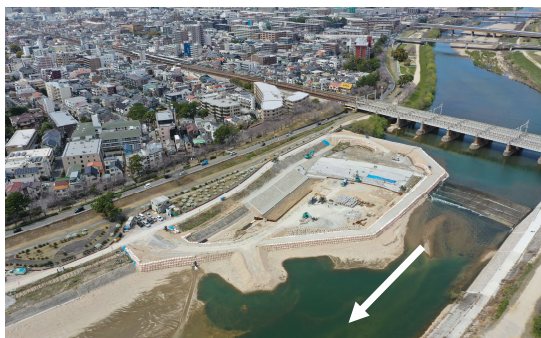
護岸整備、3号床止改築 武庫川（尼崎市・西宮市）
