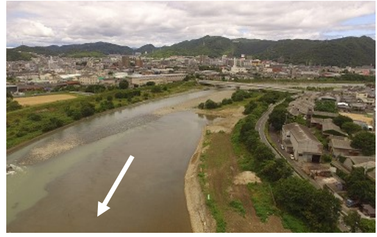
河床掘削 市川(姫路市)
