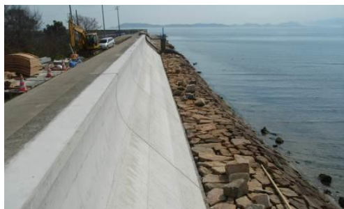
【御津海岸・護岸補修】
