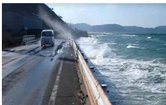
【鳥飼海岸（洲本市）・施工前状況】
