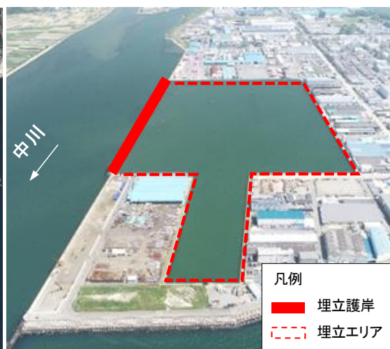
【浜田地区(廃棄物埋立護岸・埋立)】
