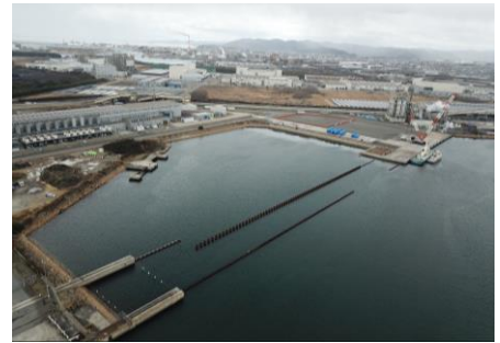
【姫路港広畑地区(-14m 岸壁・新設)】
