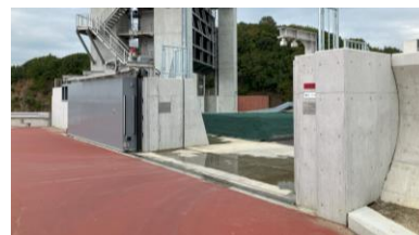
【阿万港海岸・陸閘】
