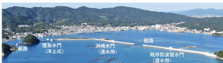
【福良港海岸・湾口防波堤】
