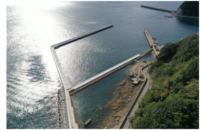
【家島港網手地区 物揚場整備】
