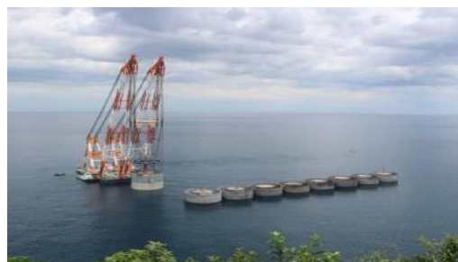
【柴山港(防波堤)・新設】
