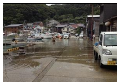
【柴山港海岸・浸水状況】
