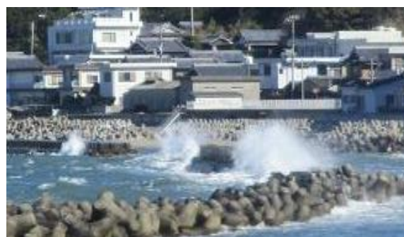
【阿那賀組海岸（南あわじ市）・施工前状況】
