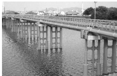
水管橋の耐震補強（市川水管橋）
