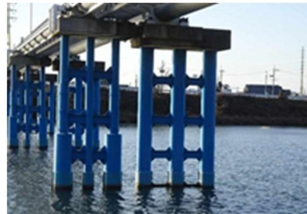
水管橋の耐震補強（市川水管橋）
