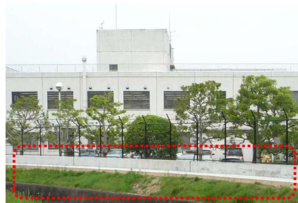
浸水防止用擁壁（船津浄水場）
