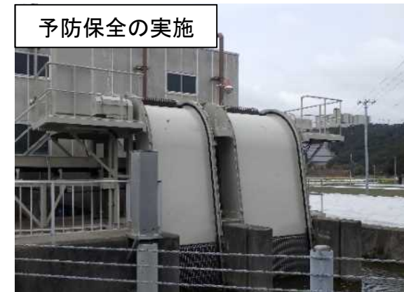
除塵設備の更新（令和3年度）
