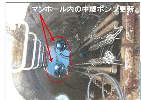
施設の機能強化事例 （三田市 三田地区その1(母子地区)）
