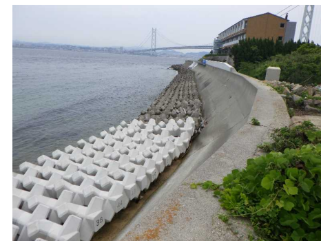
改修中の松帆崎（まつほざき）海岸
