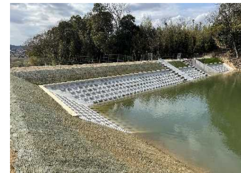
豪雨対策工事が完了したため池 (三田市 新池)
