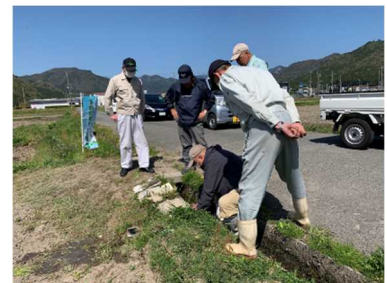
活動組織による水路の点検・診断 (多可町)
