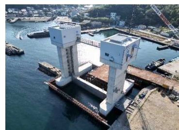
沼島港口水門の施工状況 （南あわじ市）
