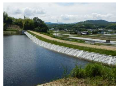
改修工事が完了したため池 （洲本市）
