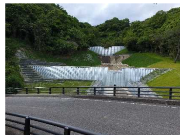
市街地を保全する治山ダム （神戸市）
