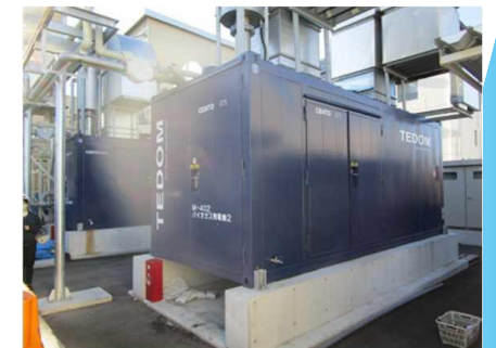
食品残さを活用したバイオマス発電プラント（ecoモデルの事例）
