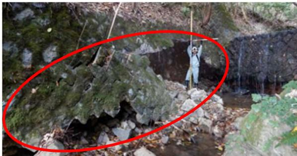
基礎部が破損した床固工、護岸工 (養父市)
