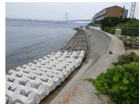
改修中の松帆崎（まつほざき）海岸（淡路市）
