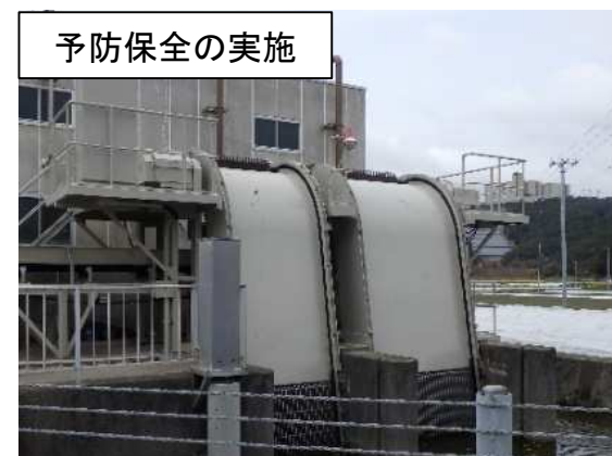
除塵設備の更新（令和3年度）
