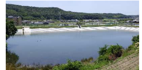
豪雨対策工事が完了したため池 (神戸市西区 尻池)
