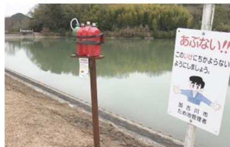
堤体に設置された救命用ペットボトル
