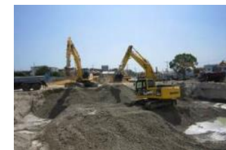
土壌汚染対策の実現場
