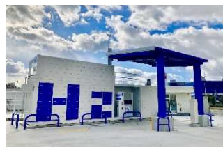
エア・リキードMK神戸空港前水素ステーション
