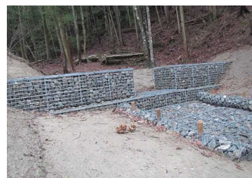
里山防災林整備(簡易防災施設) (神戸市北区)
