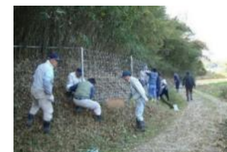
獣害防護柵の設置(加東市)
