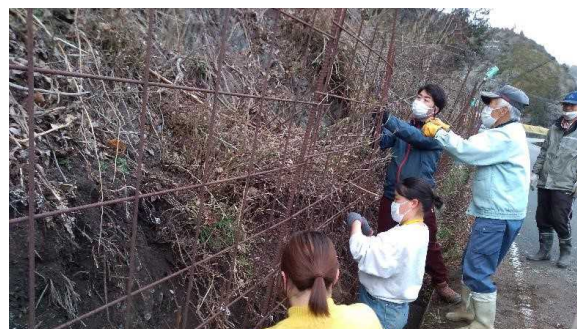
自治会と学生共同での 獣害対策用防護柵の設置
