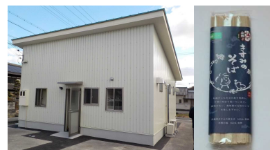
新たに建設した製粉施設と新商品「乾そば」
