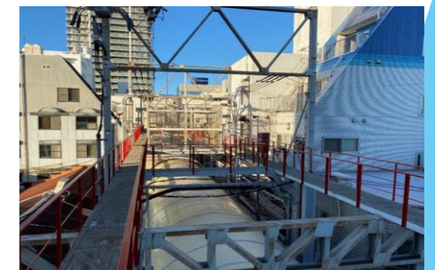
アーケード改修 (屋上歩廊修繕)
