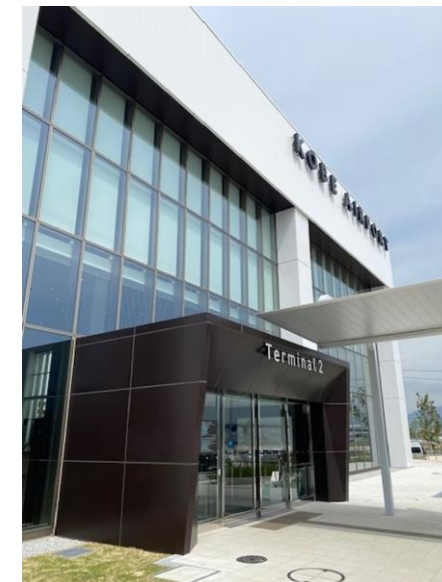
神戸空港新ターミナルビル
