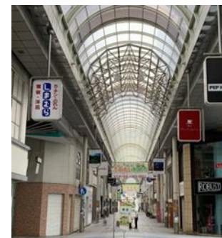
アーケード改修 (稼働屋根制御盤の改修／姫路市)
