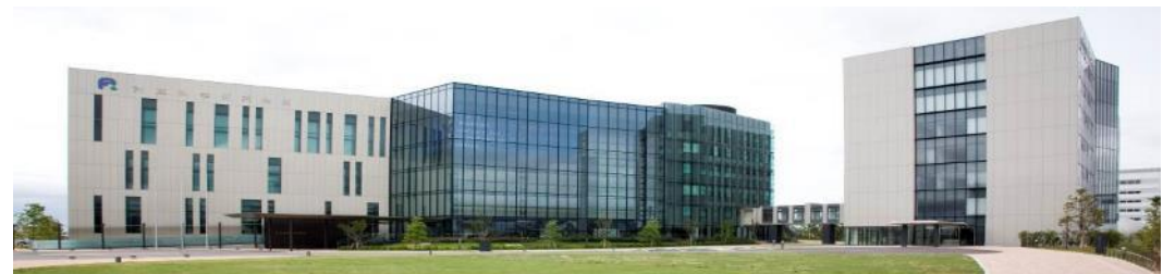
スーパーコンピュータ「富岳」施設
