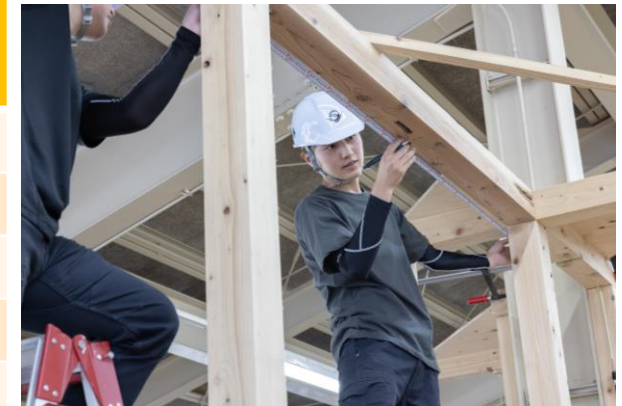
木造建築施工実習（建築工学科）
