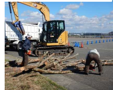
▲ 道路啓開作業（実働）
