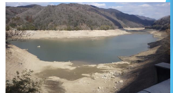
吞吐ダムの渇水状況（R7.2 三木市） 「加古川水系広域農業水利施設総合管理所」提供
