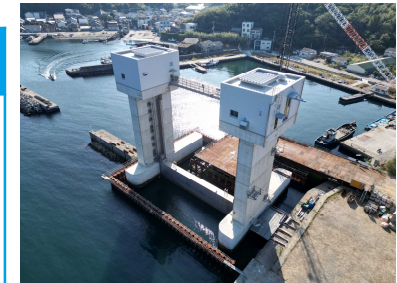
沼島漁港 水門整備
