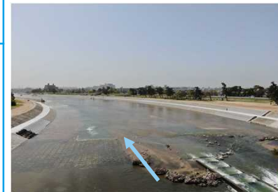
武庫川 河川改修
