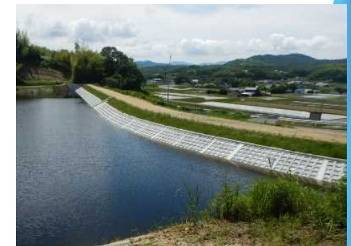
改修工事が完了したため池 (洲本市)
