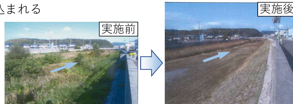
千草川 堆積土砂撤去（洲本市）
