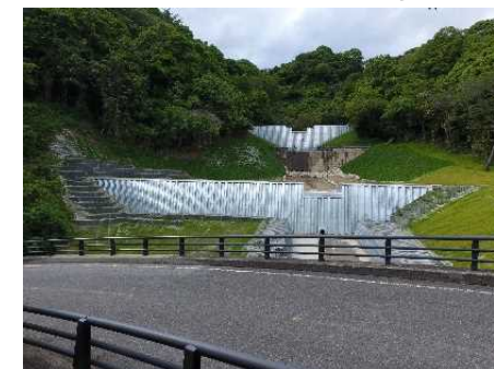
市街地を保全する治山ダム (神戸市)
