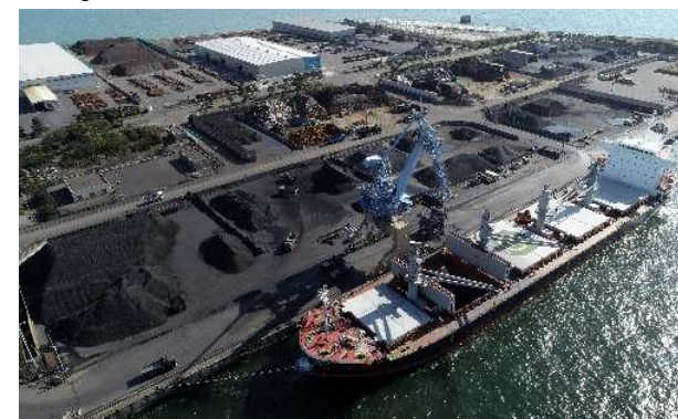
姫路港中島地区 公共ふ頭（姫路市）
