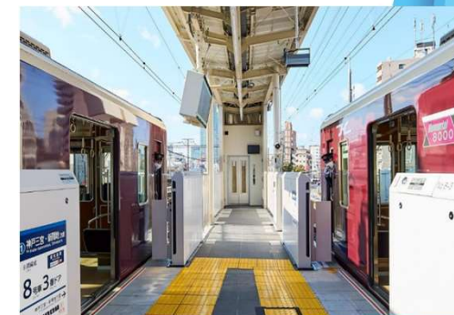
写真2 エレベーター設置（阪急春日野道駅）
