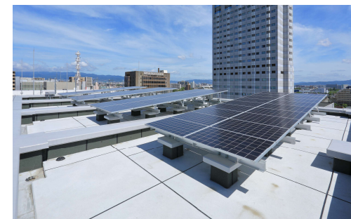
写真13 県有施設における屋上への太陽光発電設備設置の事例
