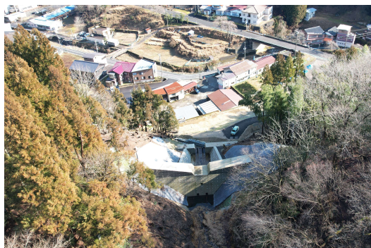
天地面川 砂防堰堤（新温泉町）
