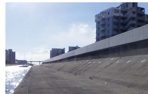
尼崎西宮芦屋海岸 枝川町地区 防潮堤嵩上げ（西宮市）
