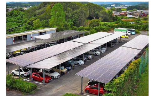
PPA方式による県施設へのカーポート型太陽光発電
