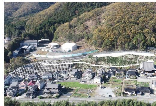
五十波地区 急傾斜地対策（宍粟市）
