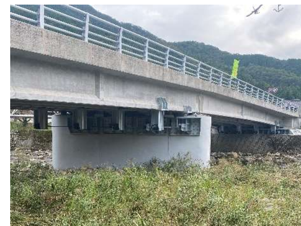
県道 加美穴栗線 山田橋 橋梁耐震補強（神河町）
