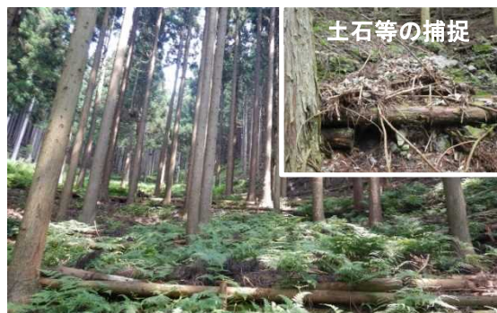
伐倒木を利用した土留工（朝来市）
