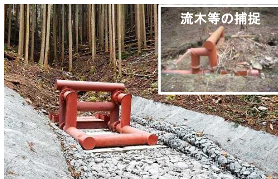
簡易流木止め施設（姫路市）
