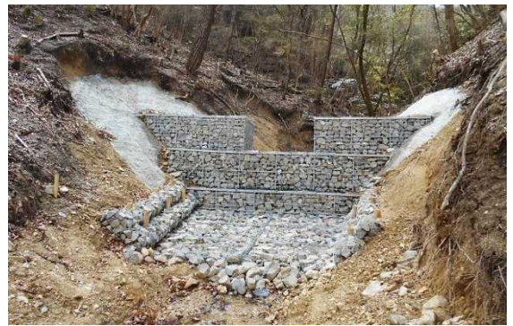
小崩壊地での簡易防災施設の設置（神戸市北区）
