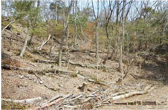
広葉樹を抜き伐り、土留工を設置（神戸市北区）
