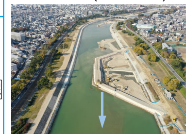
武庫川 河川改修(1号床止撤去)
