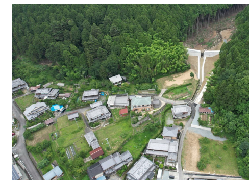
古瀬畑川 砂防堰堤 (姫路市)
