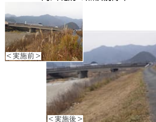
河川堤防の点検前除草
