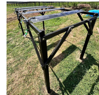
ペロブスカイト太陽電池を活用した営農型太陽光発電設備のイメージ
