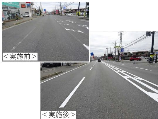
道路区画線の引き直し
