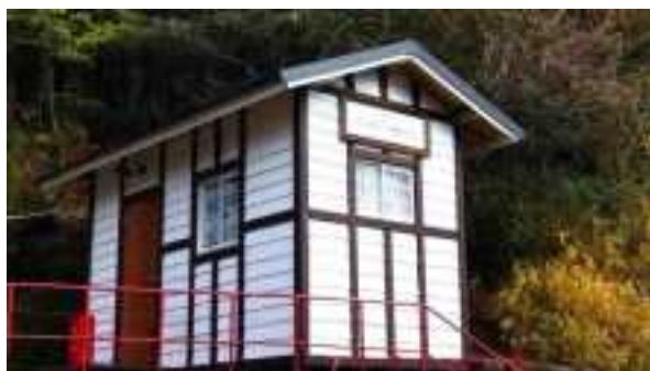
完成した小屋
