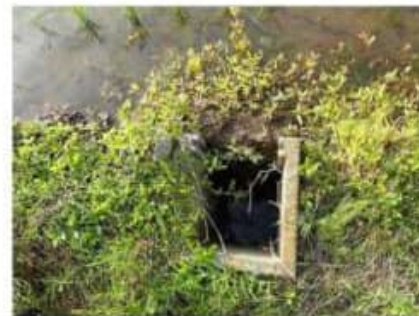
給水栓付近から定着
