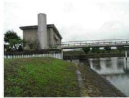
排水機場の法面
