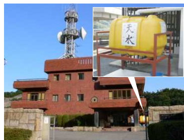
一庫ダム管理所の玄関(水資源機構)
