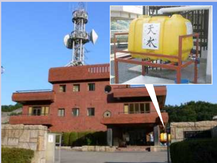
一庫ダム管理所玄関横の雨水貯留タンク
