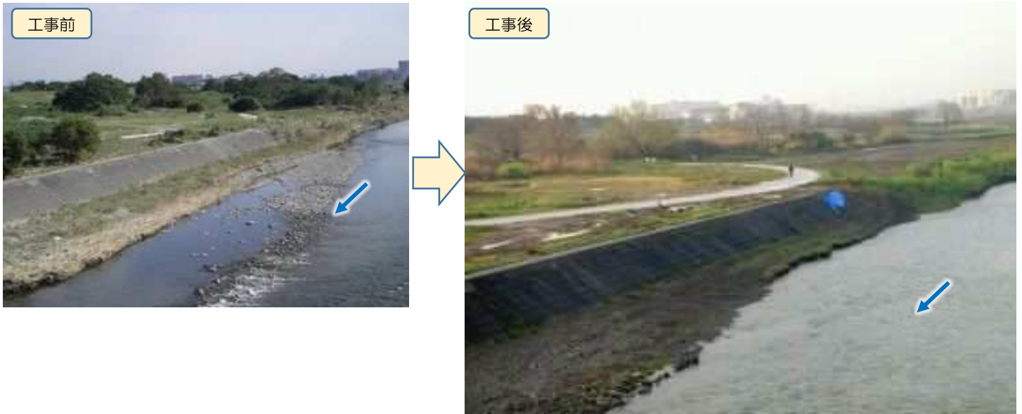
猪名川下川原地区 河床掘削
