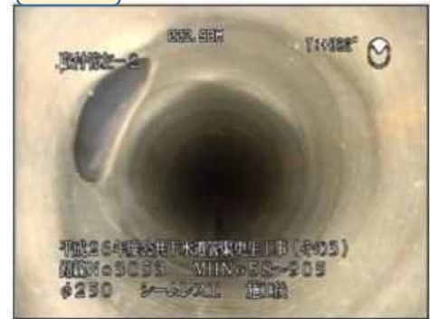
公共下水道管の管渠更生工事
