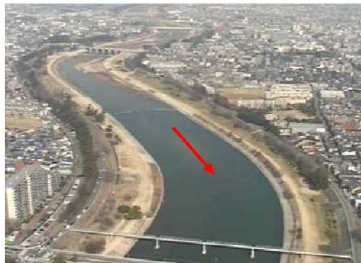
図 2-3 下流部築堤区間
