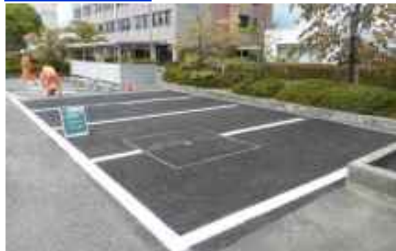
【駐車場】 兵庫県伊丹庁舎
