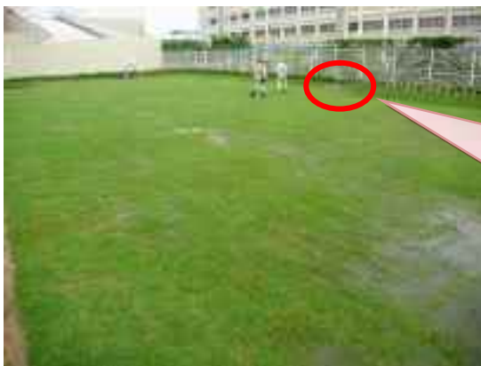
凹地(芝生エリア)に雨水が貯まりやすいよう、排水口を狭めている(オリス構造)。
